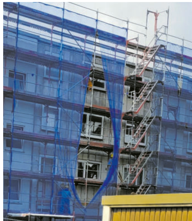
Die Häuser in der Möllenkotter Straße in Schwelm sind eingerüstet, die Arbeiten haben 2024 begonnen, und für die Mieter begann der Ärger.
